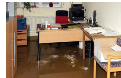
Überschwemmung im Büro des Altenheims
